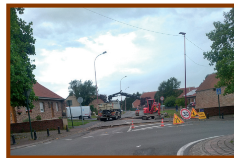
Travaux d'assainissement rue Oscar Desmaretz
