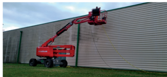
Gros nettoyage de la façade de la salle Gatien
