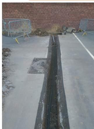
Réfection d'une conduite d'eau à l'école primaire Joliot-Curie
